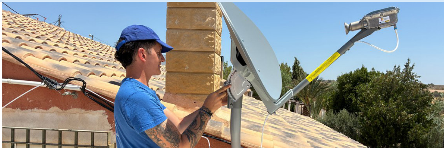
Técnico de Avanza durante una instalación.
